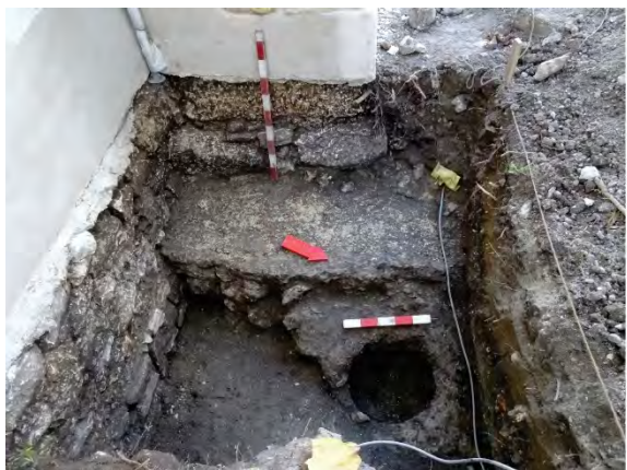
Figura 34. Groapă în șapa de nord a fundației celui mai de vest contrafort perpendicular nordic; vedere de ansamblu (a) și detaliu (b) / Hole in the mortar layer of the foundation of the westernmost northern perpendicular buttress; overview (a) and close-up (b).
